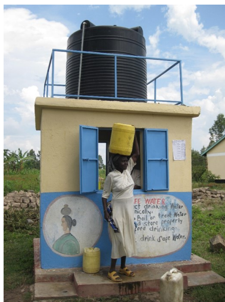
Dit is een waterkiosk. Hier kunnen mensen veilig drinkwater kopen tegen een klein bedrag. Een soort van mini drinkwaterbedrijf. Door te betalen voor het water, kunnen de watervoorzieningen onderhouden worden en indien nodig gerepareerd worden. Het water wordt nog steeds wel in jerry-cans gehaald en op de hoofden van de vrouwen vervoerd.
